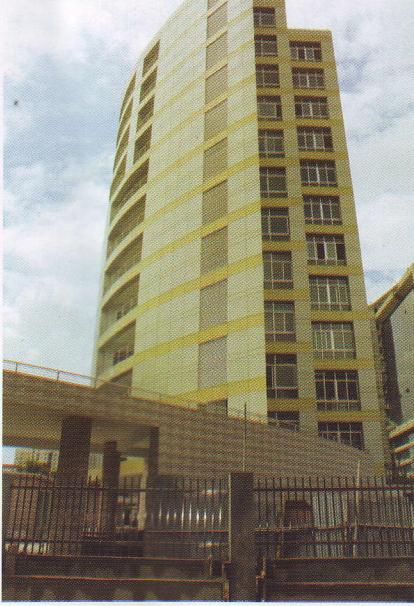
নির্মাণাধীন ইটিআই ভবন
